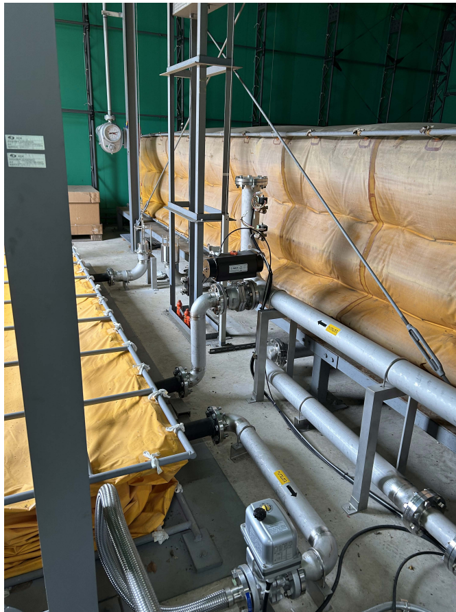
図 2.12: クエンチ発生後後、蒸発したヘリウムを回収するガスバッグ
